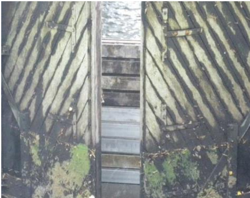
Blick aus der trockengelegten Schleusenammer durch die Tore zum Dammbalkenverschluss mit einer Wassersäule von ca. 2 m
