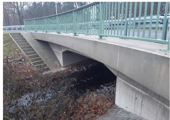
Abb. 3-17: Brücke über den Mahlower Seegraben K7239 (UBB 12/2022).
