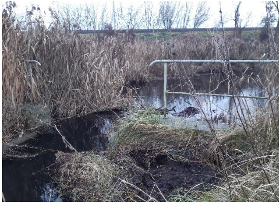
Abb. 3-14: Auslaufs der Betongerinnestrecke (UBB 12/2022)
