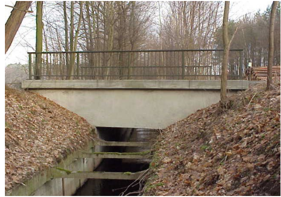
Abb. 3-15: Brücke über den Mahlower Seegraben bei Diedersdorf (LS-Brandenburg 12/2022).
