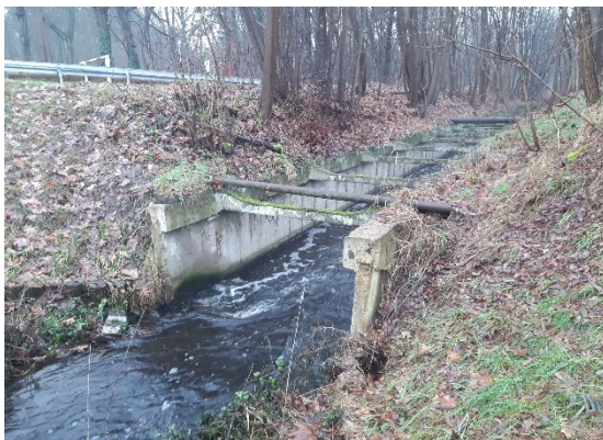
Abb. 3-16: Einlaufs der Betongerinnestrecke (UBB 12/2022)
