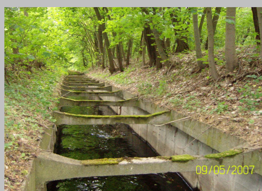
altes Seegrabenprofil mit Betongerinne und steilen Böschungen
