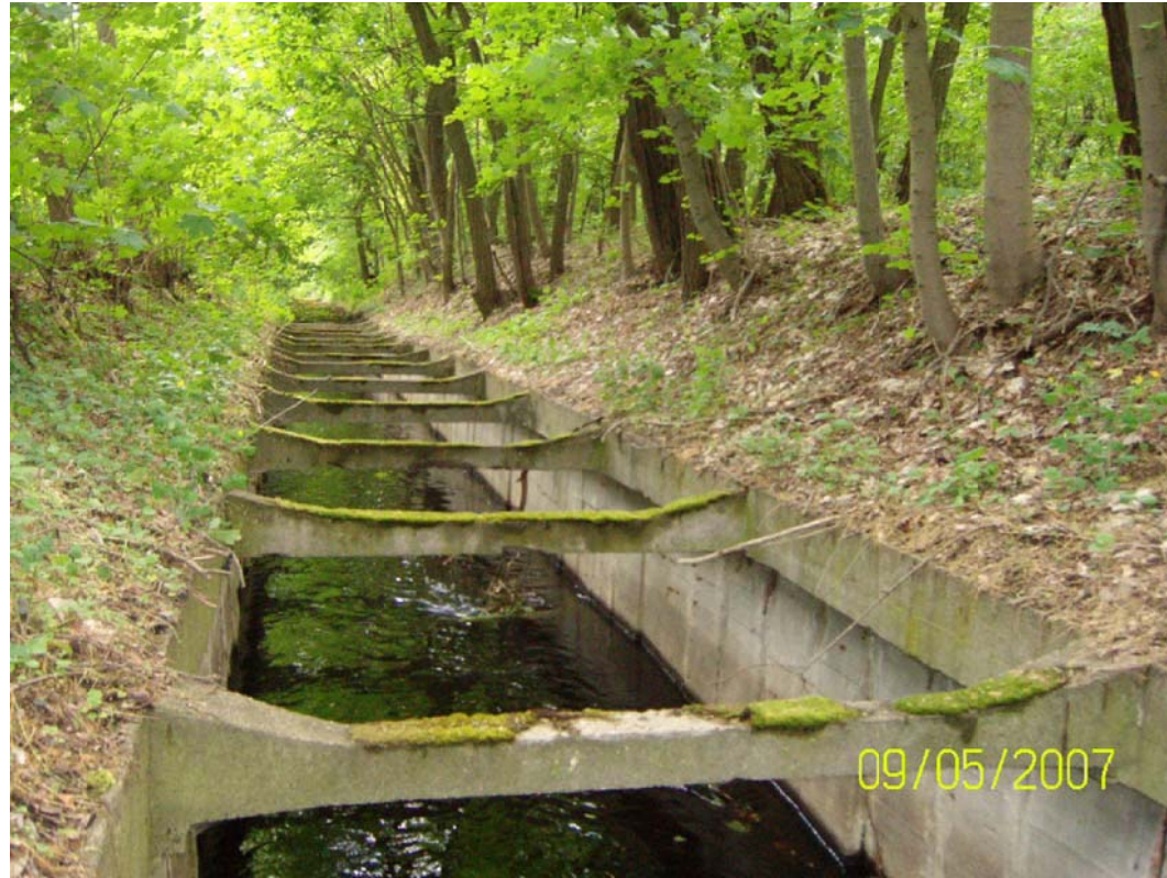
altes Gewässerprofil MSG, Blick in Fließrichtung
